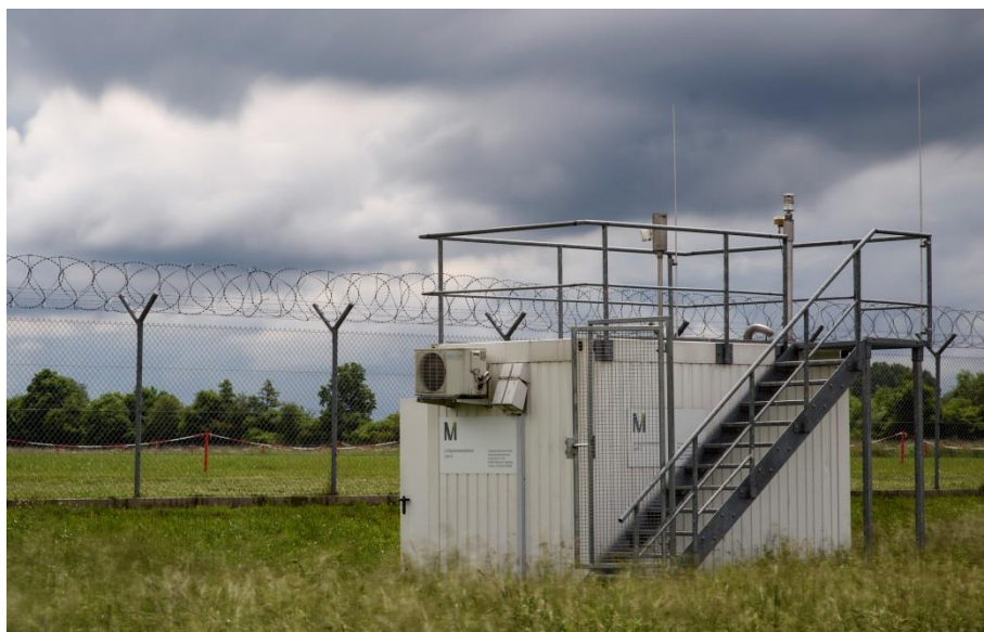
Abbildung 6. Außenansicht der lufthygienischen Messstationen (oben LHY7, unten LHY4).
