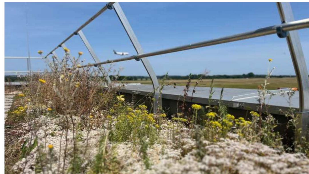
Extensive Dachbegrünung am Flughafen München [Transitgebäude]
