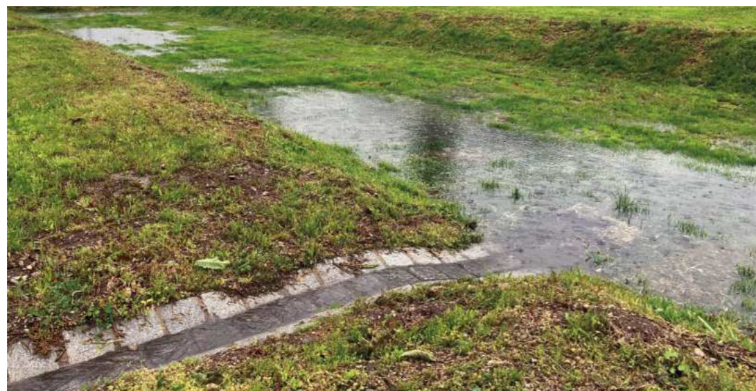
Versickerungsmulde mit Zulaufgerinne am Parkhaus P44 bei Niederschlag
