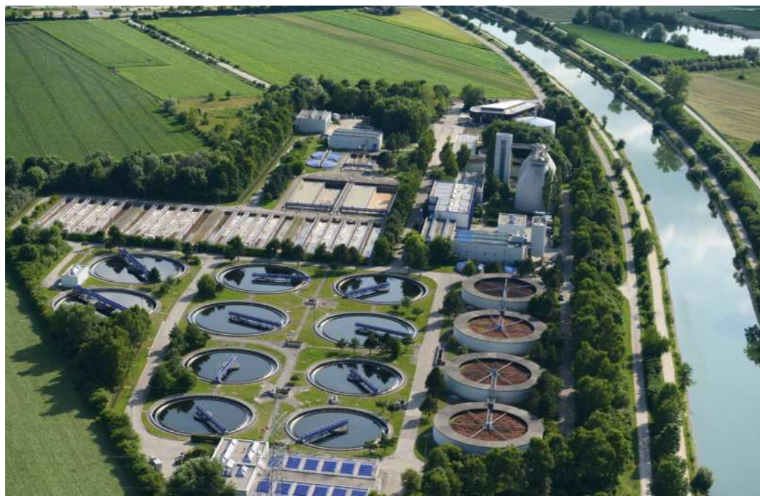
Die Kläranlage Eitting des Abwasserzweckverbands Erdinger Moos | © Abwasserzweckverband Erdinger Moos (AZV)
