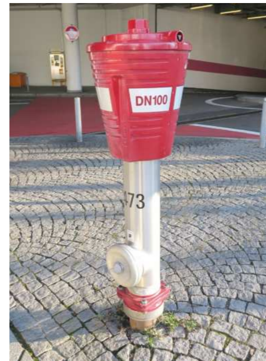
Löschwasser- und Trinkwasserhydranten
