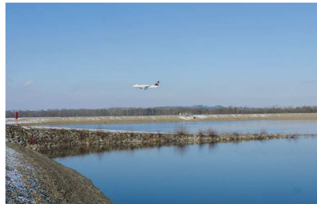
Das Enteisungsabwasserbecken des Flughafens mit einer Kapazität von 254.000 m 3
